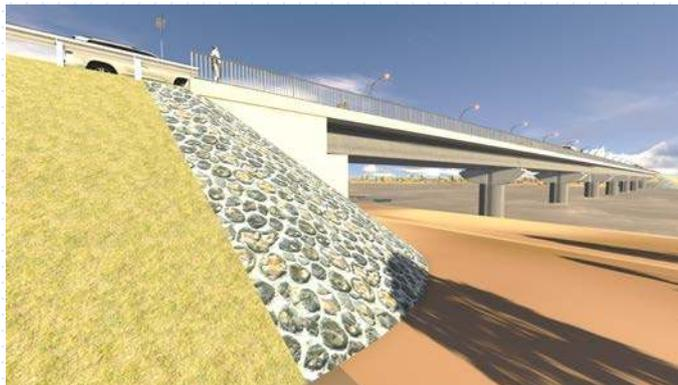
Le projet de construction d'un pont de portée 260 m avec des voies d'accès et de liaison de 50 Km dans la Région de Tambacounda permettra d'assurer de façon permanente et sécuritaire, le franchissement du cours d'eau (un affluent du fleuve Sénégal), et de jouer un rôle décisif dans le développement et l'interconnexion des réseaux routiers nationaux et régionaux.
